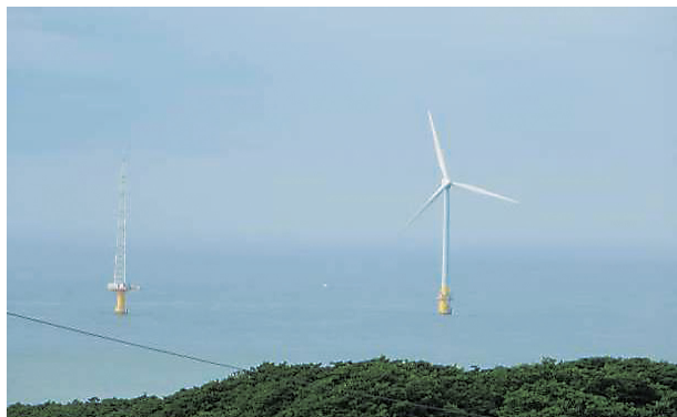
写真3 銚子沖の洋上風力発電実証研究設備
