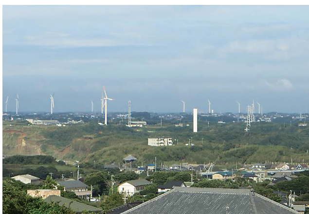
写真1 風力発電施設(愛宕山から見た風力発電群)
